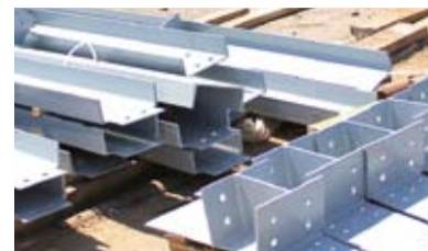
Новые элементы конструкции крыши
